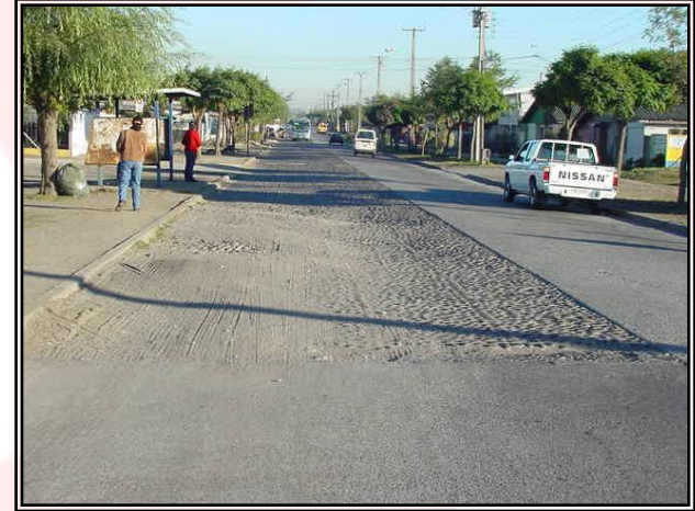
ESTADO ACTUAL CALLE BREMEN
